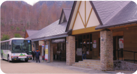
「第2駐車場」と「第3駐車場」の間に管理棟があります。この中に乗車券の販売所があります。
